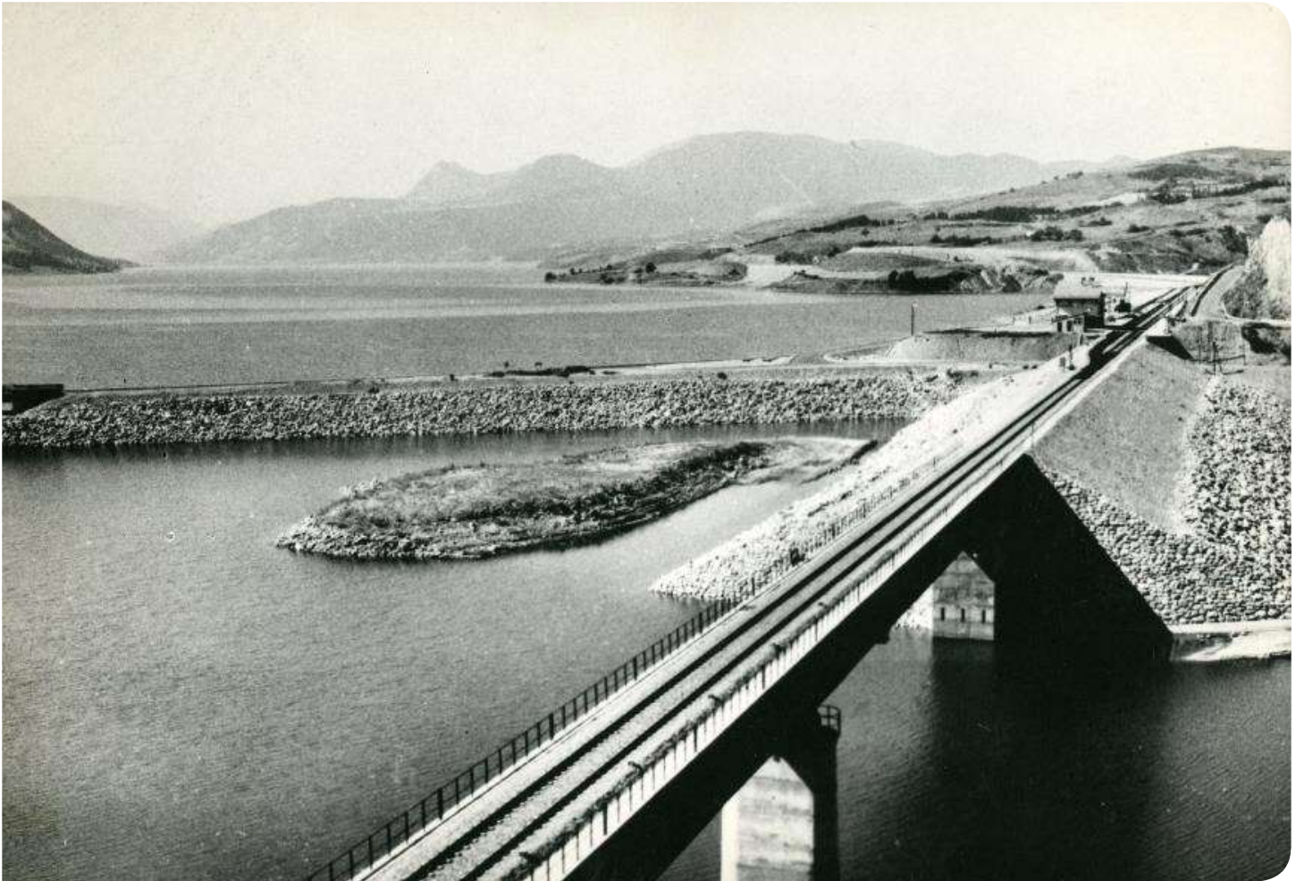
Puente ferroviario. Francia. Núm. registro 03-001692.
